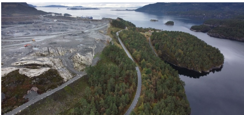
Figur 2. Dagens veg ligger plassert mellom Jelsa Stein AS sitt dagbrudd og sjøen.
